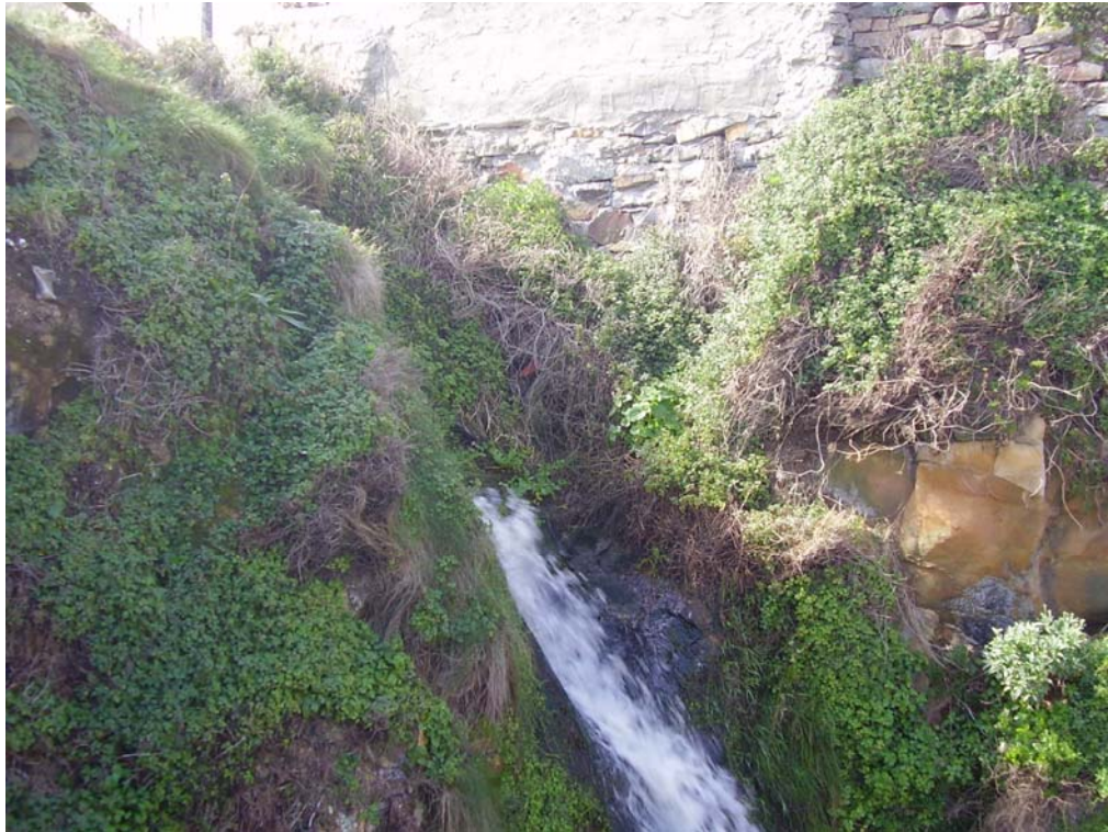
Ilustración 19.- Punto de vertido de aguas pluviales
